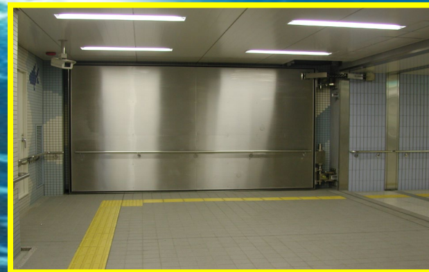
地下聯絡通道電動門扇式防水閘門動作連續圖
