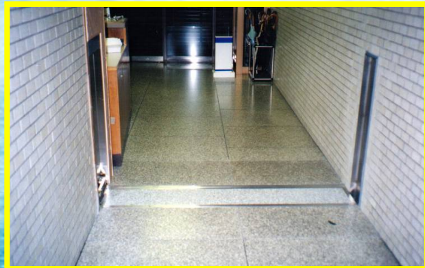
電梯口手動橫移式防水閘門動作連續圖
