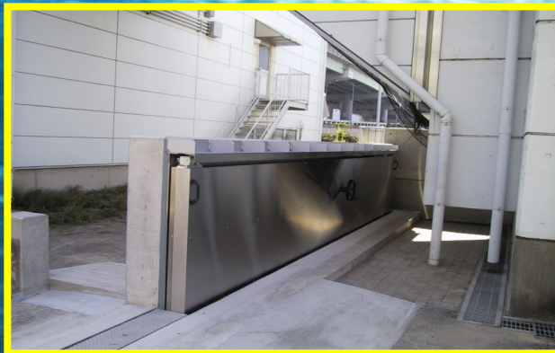
車道手動橫移式防水閘門動作連續圖
