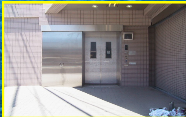
地下電氣房手動門扇式防水閘門動作連續圖
