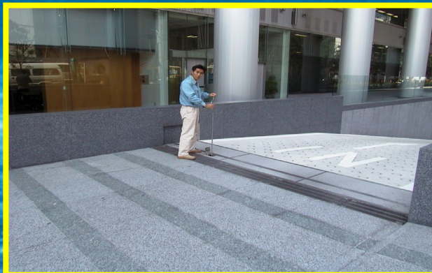
車道手動橫移式防水閘門動作連續圖
