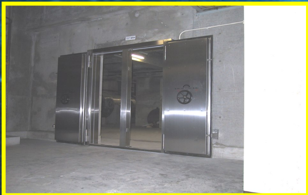
地下電氣房手動門扇式防水閘門動作連續圖
